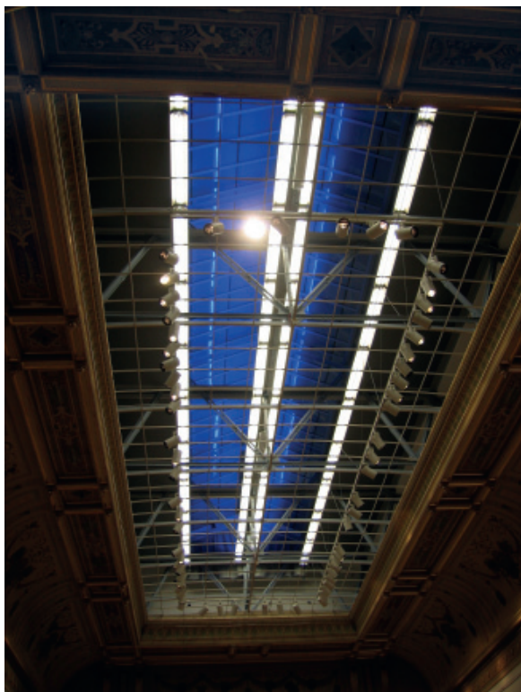
Nova rasvjeta i stakleni krov s roloima 2006.
