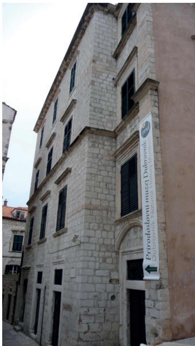
Sjeverna fasada zgrade Prirodoslovnog muzeja Dubrovnik
