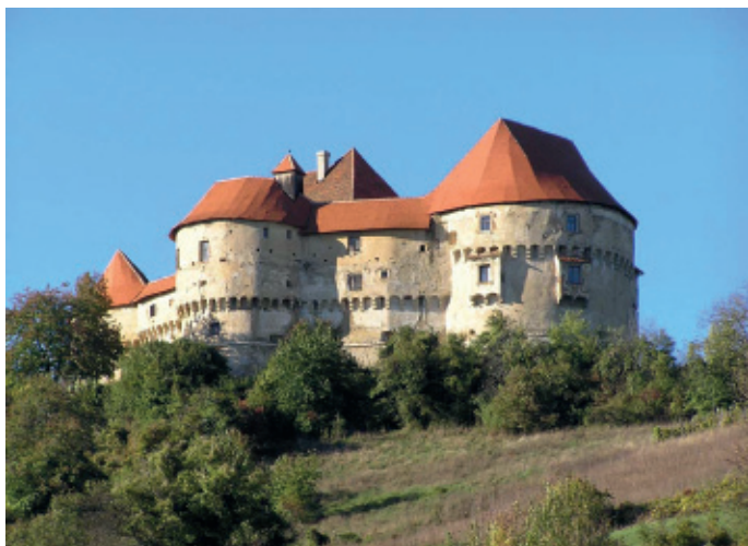
Veliki Tabor prije obnove 2004.
