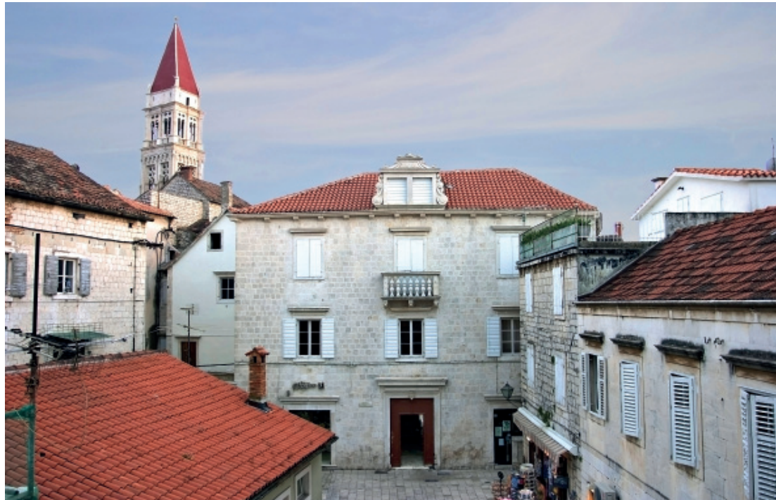
Palača Garagnin-Fanfogna / Muzej grada Trogira, nakon sanacije
