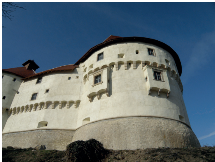
Pogled na istočnu kulu nakon obnove
