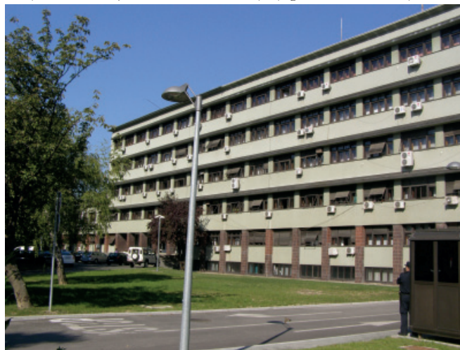
Zgrada MUP-a (arh. Horvat) u Ulici grada Vukovara (foto Željko Jamičić)
