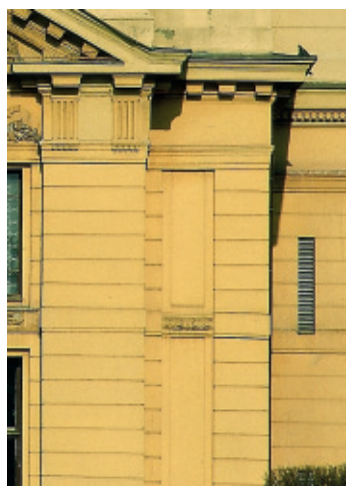
Detalj južnog pročelja prije i poslije obnove 2011.
