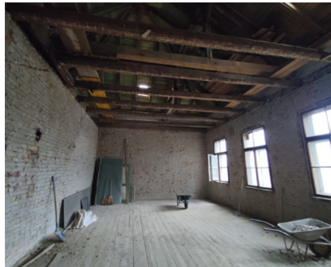
^ Slika 5. Radovi na prostoriji kata čuvaonice. Autor fotografije: Marko Klak
